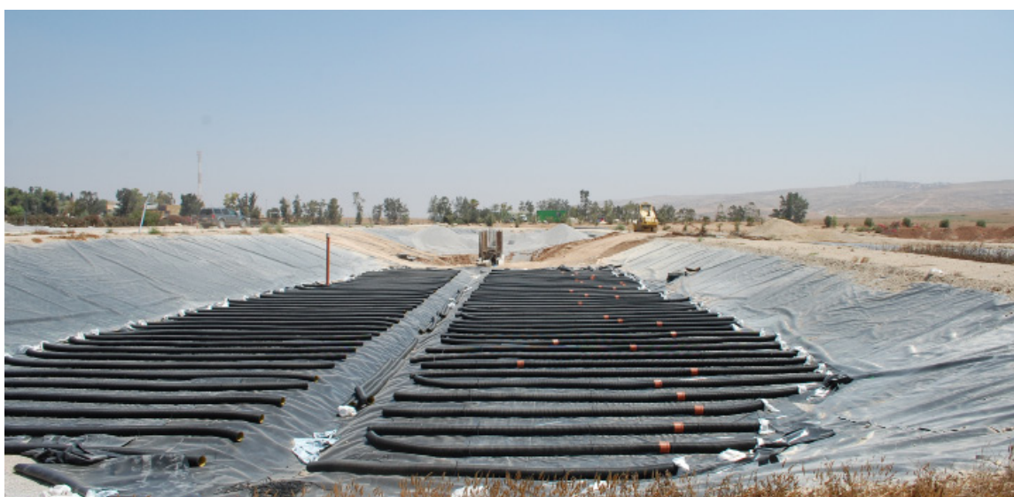
TAYA bacino in costruzione a Kibbut Lahav
